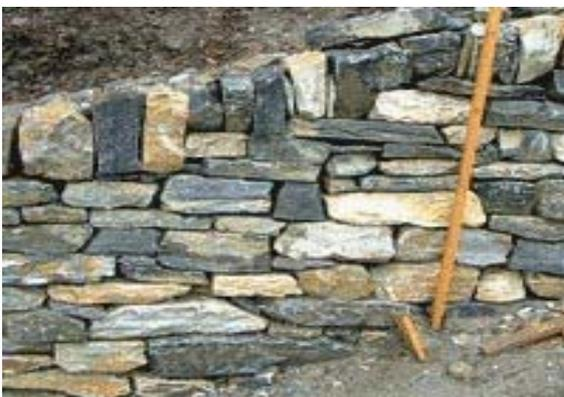
**Abb.2:** Trockensteinmauer mit offenen Fugen (Quelle: MAUERBEISPIEL n.b.B)
