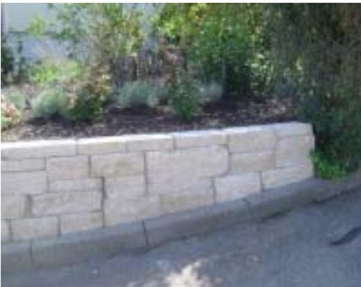
**Abb.1:** Trockensteinmauer mit geschlossenen Fugen (Quelle: MAUERBEISPIEL n.b.A)
